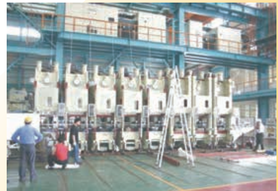
Ligne transfert 8 postes chez Faurecia (61)
