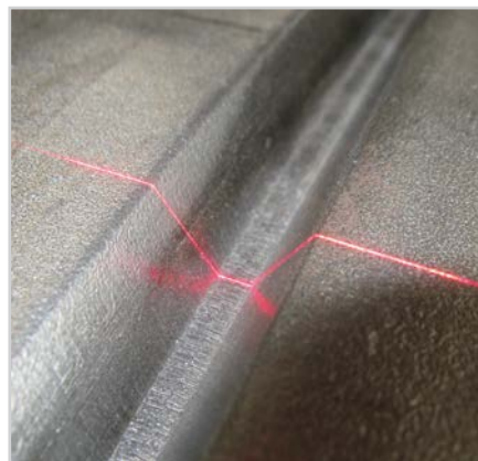
Mesure de soudures sur tuyaux
